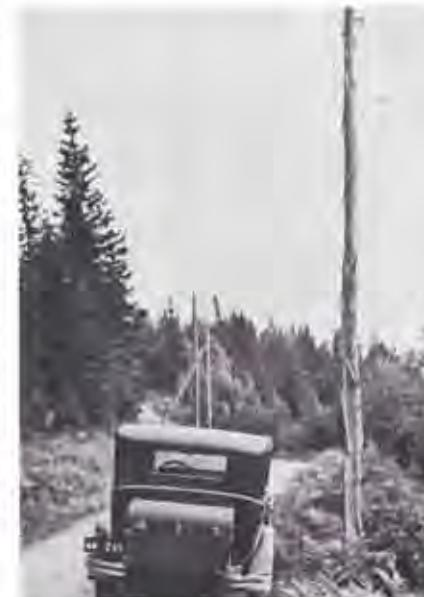
Oräkneliga stolpbyten på Sommaröarna när nätet blev dubbeltärdigt på grund av automatiseringen. Bakom bilen syns en stolpbyte. Den enkeltärdiga 3-linjers stolpen visar typiska åskskador.
