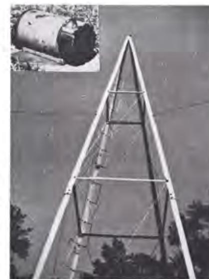
Väderstatistiken garanterade tillräcklig vindgeneratorladdning av batterierna i Sommarö elströmslösa automatcentral 1938. Under vinterkriget stod emellertid vindpropellern nästan örörlig i veckotal varför det statliga tornet monterades ner. Generatorn på 2 kW i närbild uppe till vänster.
